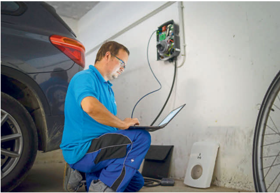
Vier Wallboxen hat Christoph Snissaert in einer Tiefgarage montiert. Damit das Laden auch richtig funktioniert, muss die Box noch programmiert werden.
